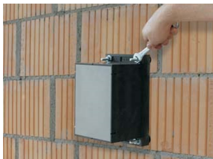
Versetzen der Universalmontageplatte UMP®-ALU-TR.
