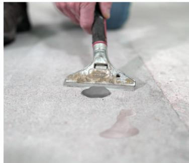
**Limpie y desengrase:** Use un limpiador o desengrasante de grado industrial y asegúrese de que el concreto esté limpio y seco antes de comenzar con la aplicación del material.
